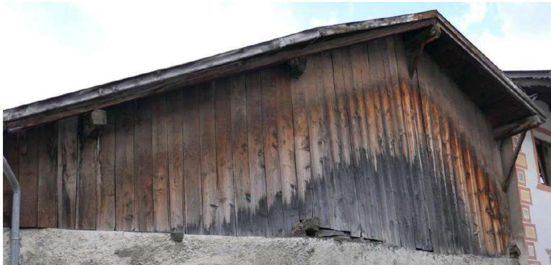
Sector de fachada protegida por vuelo de cubierta en la que se aprecia una zona superior con una afección tan solo de suciedad ambiental, una zona intermedia afectada por los UV del sol, y una más baja por la combinación UV+deslavado por la lluvia.
