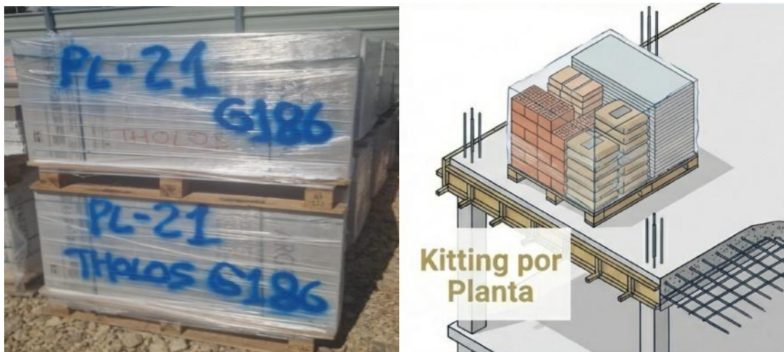
Figura 11.3.2. Fotografías obra previa de material cerámico paletizado para una vivienda. Principios Lean aplicados: Kitting / paquetes logísticos, sistema pull, Just in Time, estandarización del trabajo, reducción de muda, calidad en origen.
