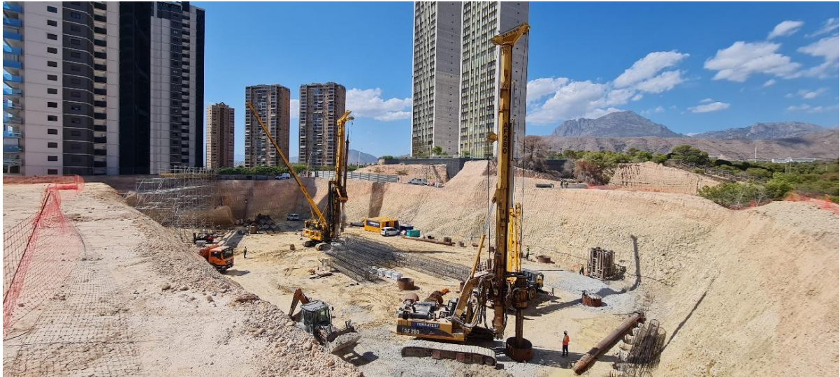
Figura 11.5-1. Fotografía de ejecución de pilotaje de gran diámetro 120cm. Septiembre 2025.
