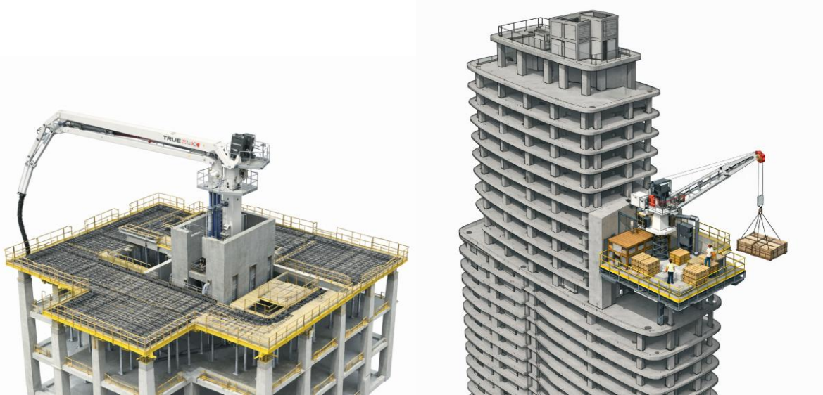
Figura 11.4-2. Izquierda, Distribuidor de hormigón. Derecha, grúa Derrick para izado auxiliar
