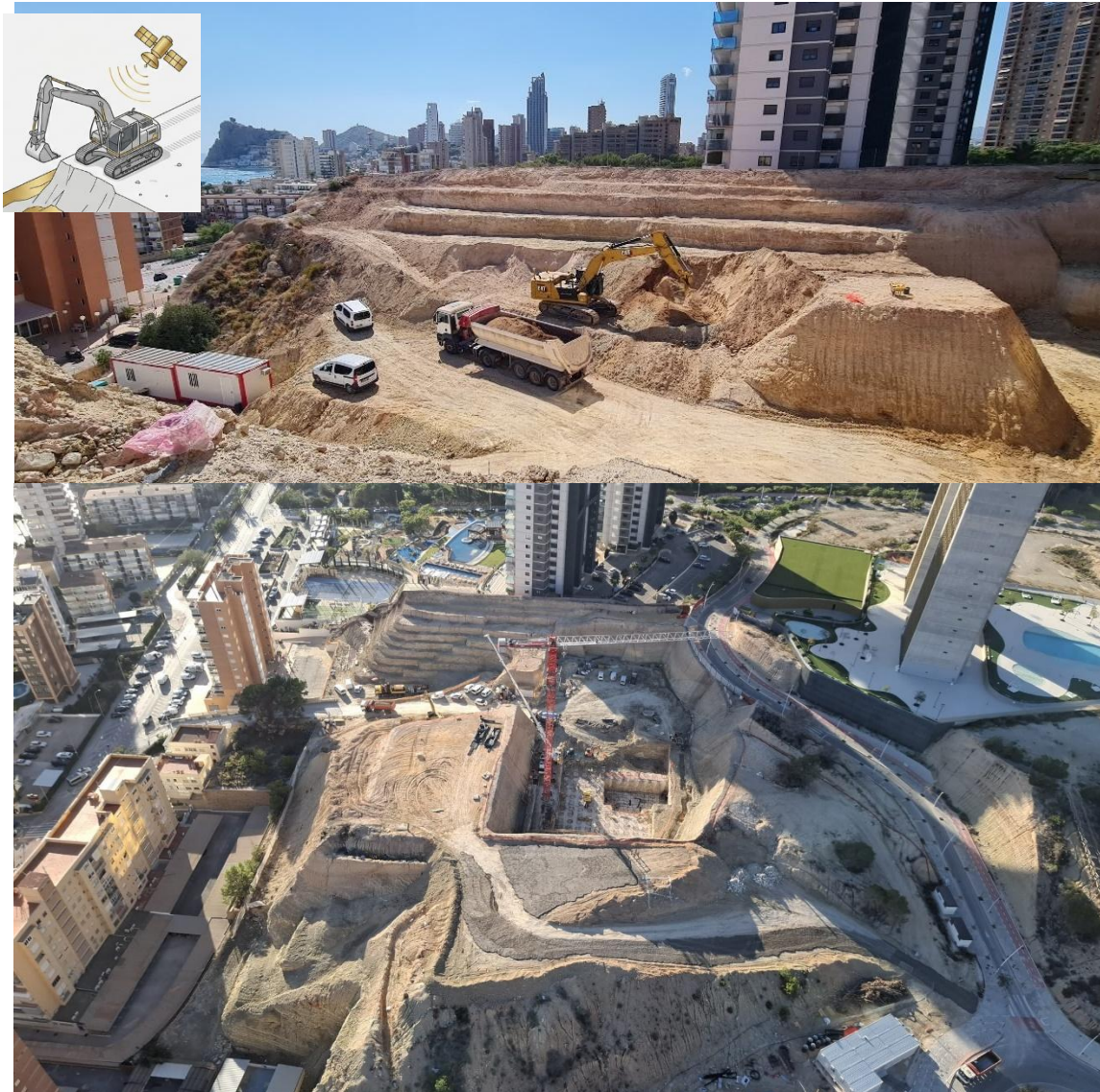
Figura 11.3.7. Fotografía obra TM Tower. Taludes esculpidos con gran precisión por excavadora con GPS. Principios Lean aplicados: Poka-yoke, calidad en origen, reducción de muda, PDCA.
