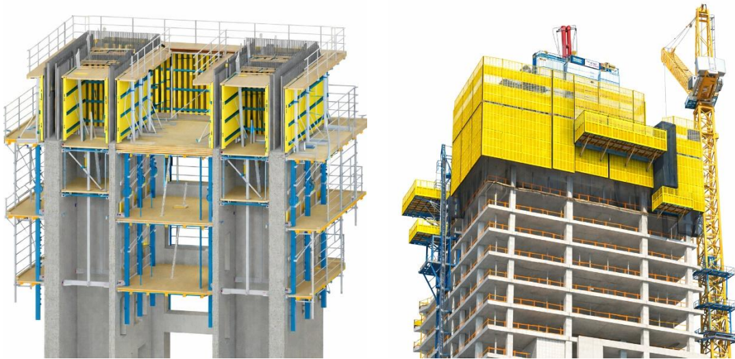
Figura 11.4-1. Izquierda, detalle de referencia de encofrado trepante para núcleos. Derecha, pantalla de seguridad para la planta completa con plataformas de acopio voladas.
