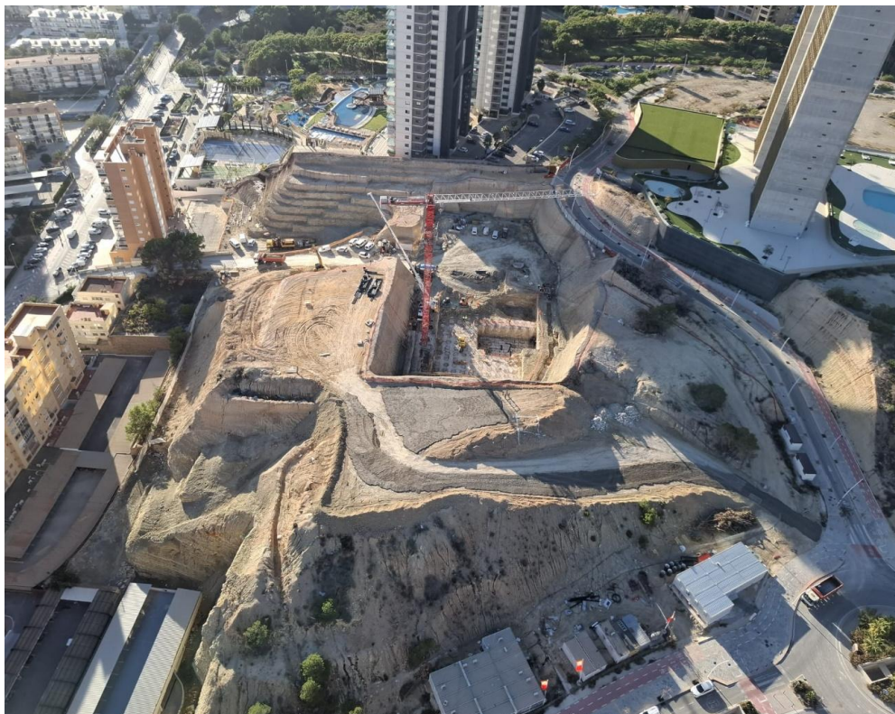
Figura 11.5-2. Fotografía del avance de obra en fase descabezado de pilotaje de zona este. Diciembre 2025.
