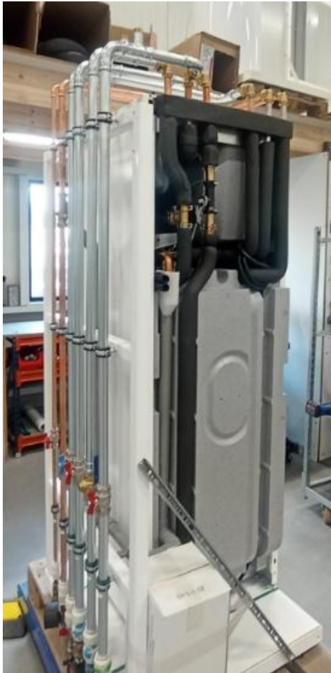
Figura 11.3.8-2 Fotografías de diferentes Mock-ups realizados en taller para la obra de TM Tower. Principios Lean aplicados: prefabricación e industrialización, DFMA (Design for Manufacturing and Assembly), calidad en origen (built-in quality), estandarización del trabajo, poka-yoke, reducción de muda y desplazamiento de complejidad constructiva hacia entornos industriales controlados (off-site production).
